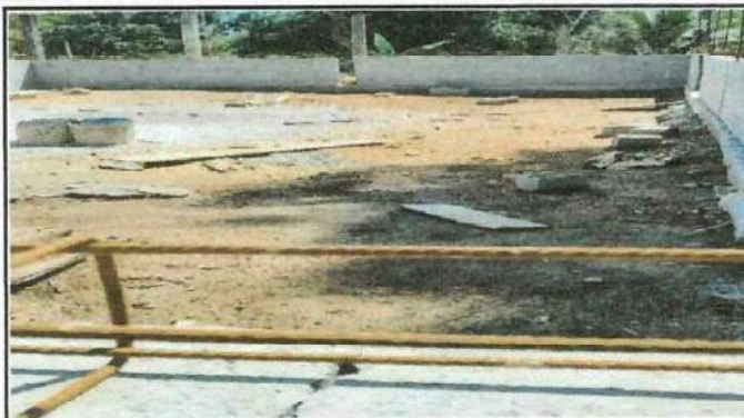
Foto 2: Fundición de losa de piso
