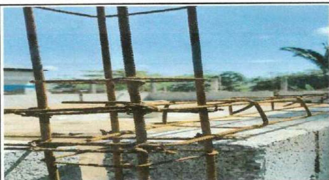
Foto 3: Fundición de columna
