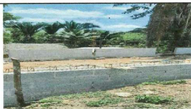
Foto 6: Instalación de balcones frontales
