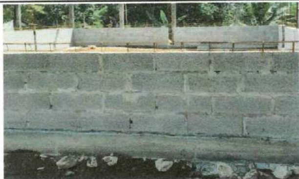
Foto 1: Fundición de solera
