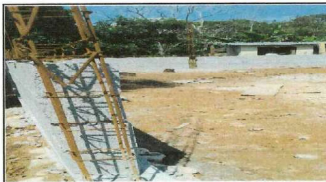
Foto 4: Fundición de columna
